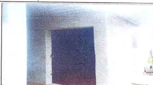
No. 2 Sustitución de puertas del baño
