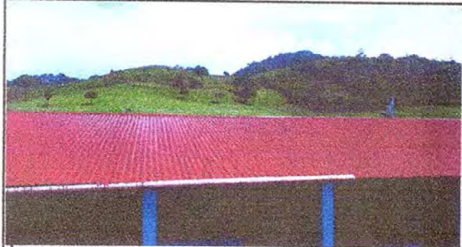
No. 1 sustitución de pintura de laminas
