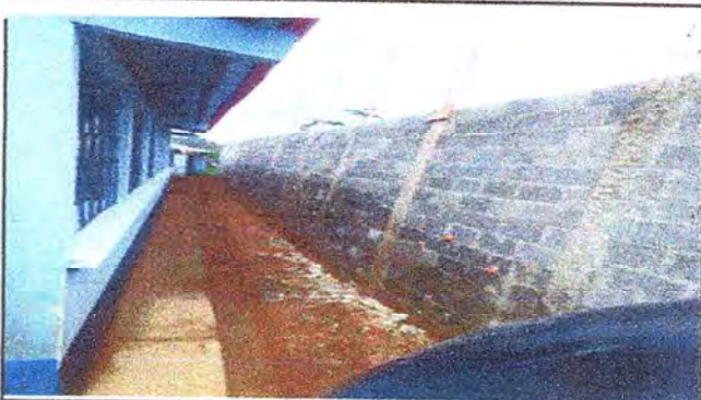
No. 10. Sustitucion de cerco perimetral.
