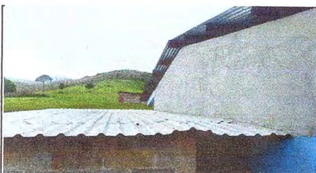
No. 09 sustitución de repello por deterioro de pared
