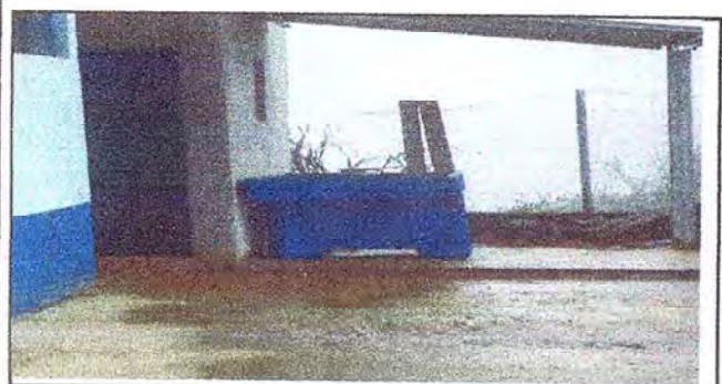
No. 11 SUSTITUCIÓN DE UNA PILA DELA COCINA
